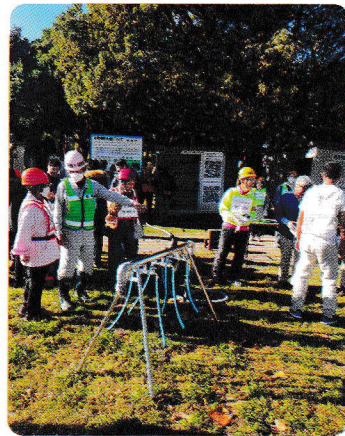
蛇口をつけて給水
