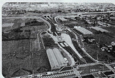
ゲート及び取り付け道路付近
