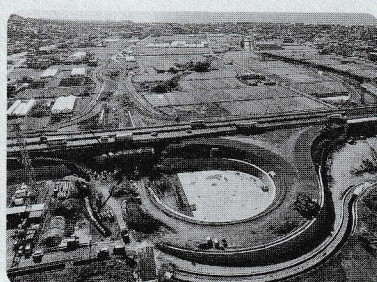
工事中のIC(左東京 昨年11月)
